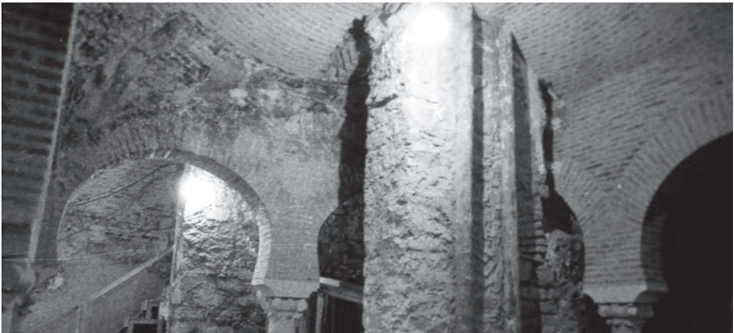
Baños Árabes. Jaén. Muros de cimentación del edificio del Palacio en la sala templada.
